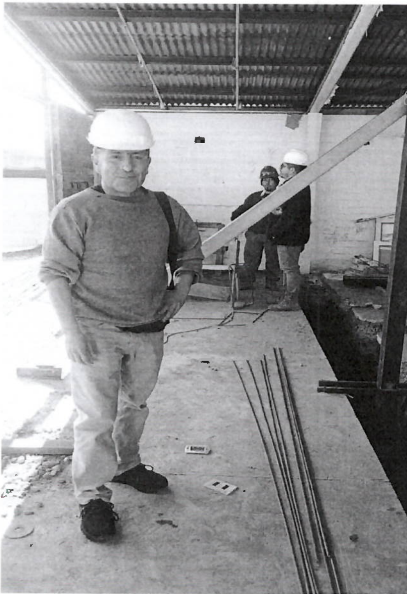
Fig3. Visitas inspectivas a Terreno Revisión verticalidad pilares
