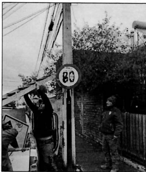
11. Santa Sofía & San Fernando, acera nor poniente.
