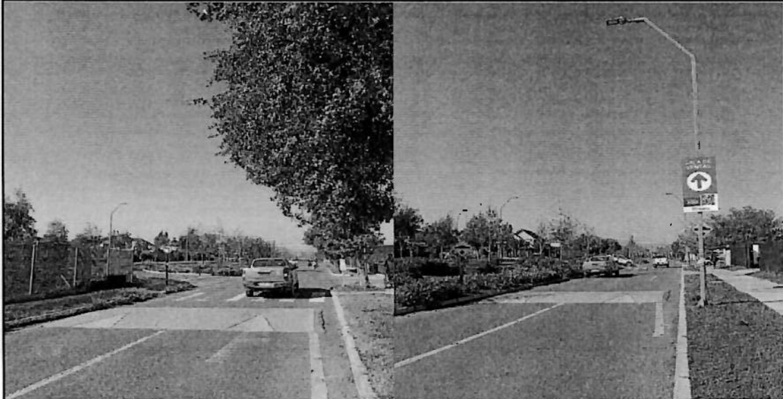
Av. Sta. Herminia c/ Las Velas (Calzada Poniente)
