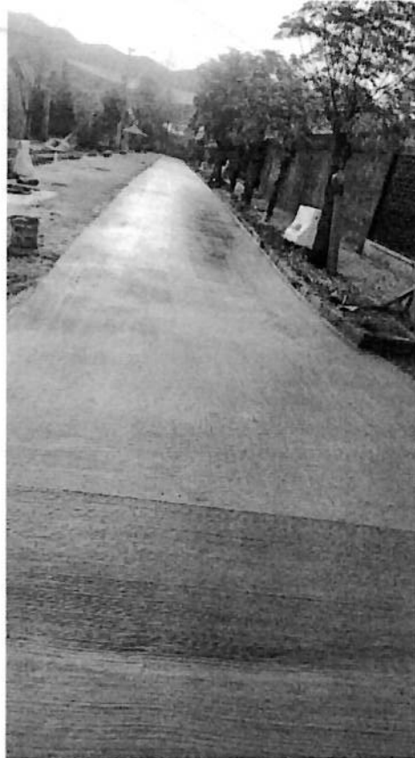
HORMIGONADO PASAJE LOS CIPRESES
