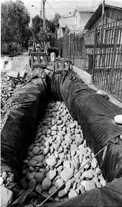
RELLENO DE DREN PASAJE LOS CIPRESES
