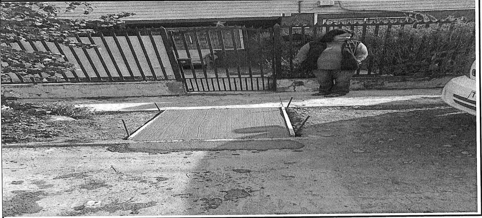
CALLE RIO ÑUBLE FRENTE AL N° 1408
