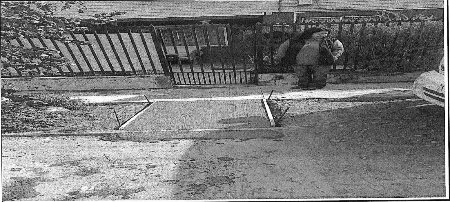
CALLE RIO ÑUBLE FRENTE AL N° 1408
