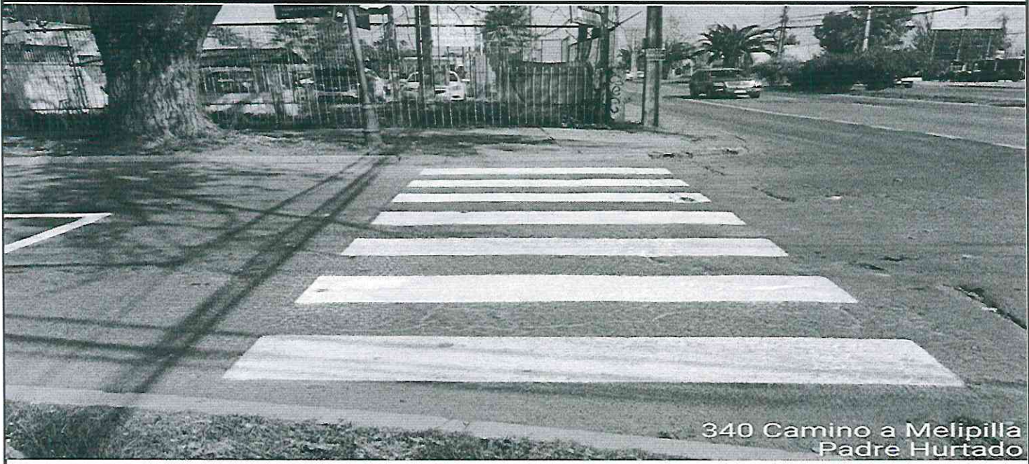
CAMINO MELIPILLA CON TERCERA AVDA.
