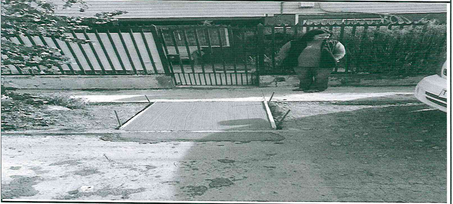
CALLE RIO ÑUBLE FRENTE AL N° 1408
