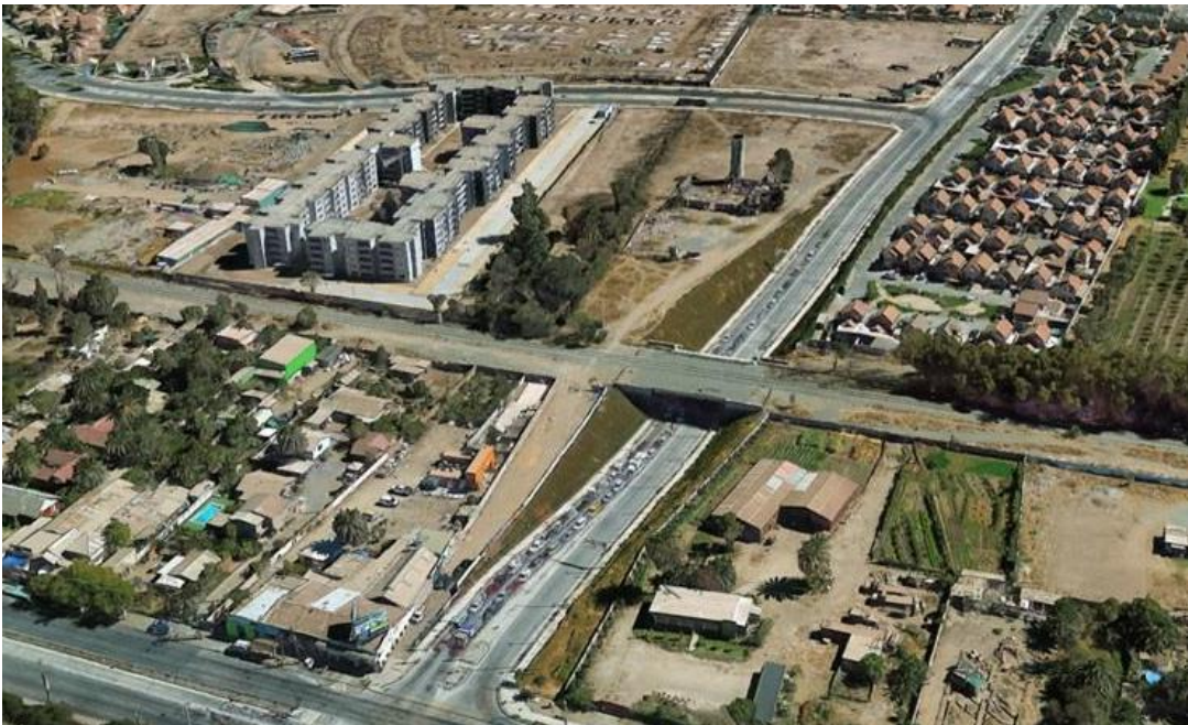
FIGURA 2-15: Vista aérea virtual sector San Ignacio, Santa Herminia y Línea del Ferrocarril.
