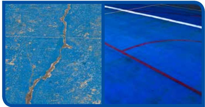
Reparación del piso de la sala de enfermería, el que se encuentra deteriorado y no en las condiciones que debiera tener, se considera un porcelanato blanco de fácil limpieza y liso, con el fin de cumplir con las normativas orientadas al área de salud y sus exigencias.
